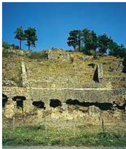
Cargadero de mineral
